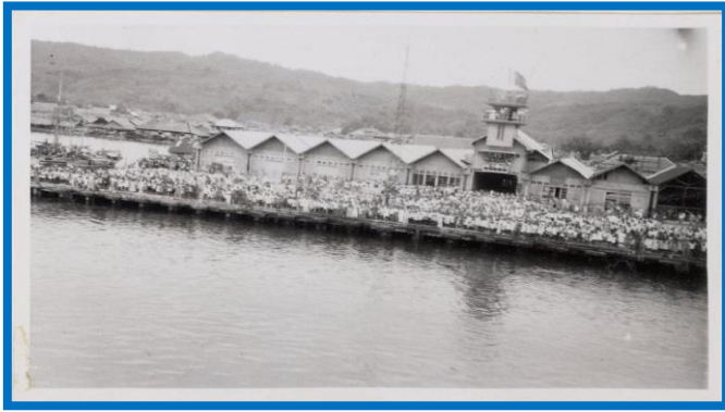
Dermaga Pelabuhan Ambon serta ruang tunggu dan gudang yang telah mengalami proses renovasi. 162
