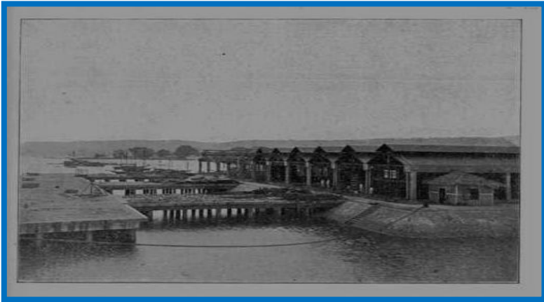
Dermaga Pelabuhan Ambon yang diperkuat kontruksi betonnya pada tahun 1919. 160
